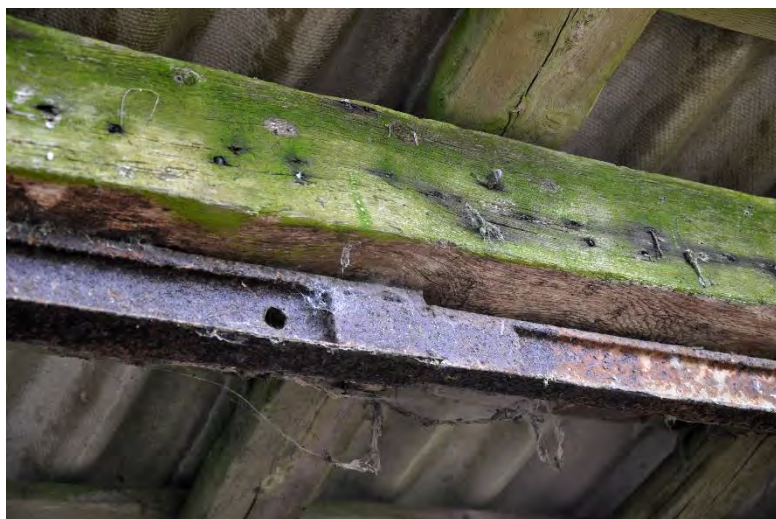
Abb. 5 Schmalspurschiene einer Lorenbahn im Vieh-Unterstand im Steinbruch (Foto 27.03.2023)
