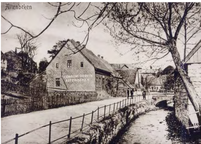
Abb. 33: Ehemalige Ufermauer der Beke im Bereich der Kreisstraße links Konsumgenossenschaft, rechts Remise des Hofes Schrader, vulgo Röttger (Foto Gemeindearchiv Altenbeken)
