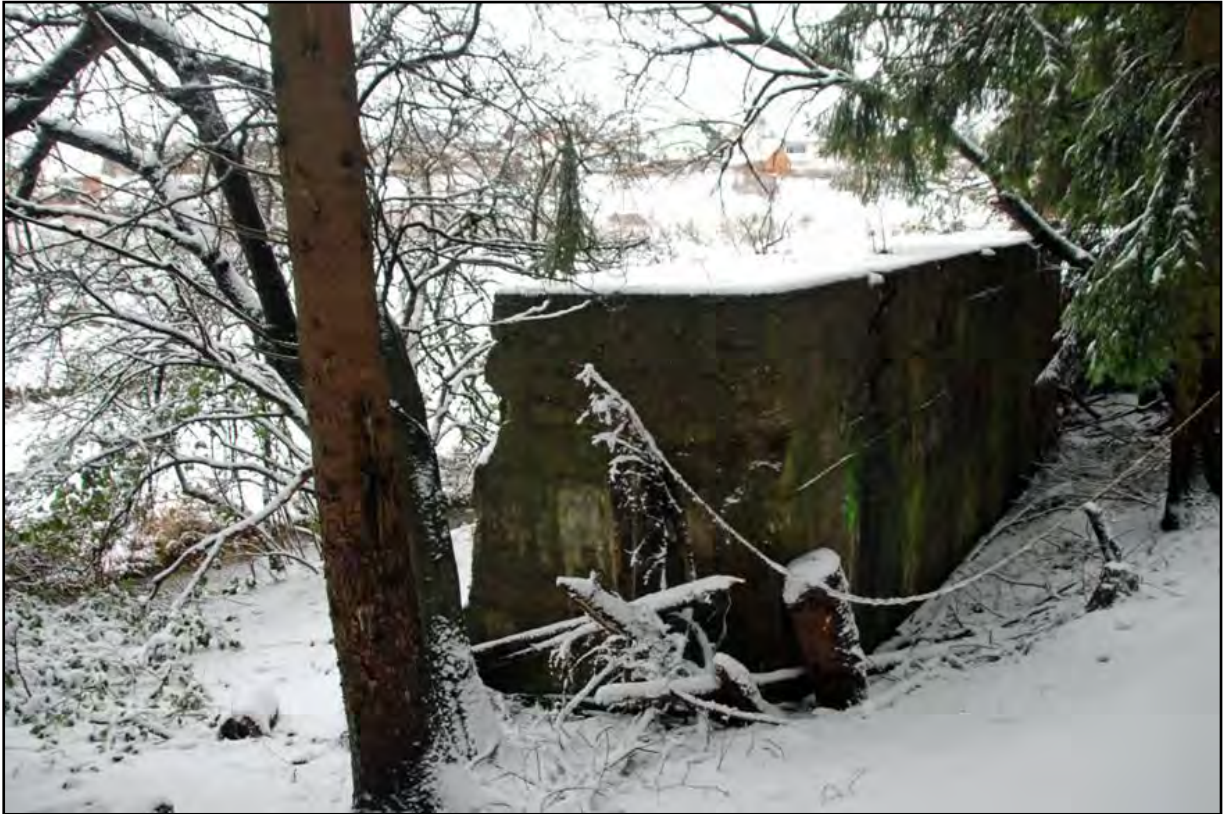
Abb. 13: Betonfundament der geplanten Bahnumgehung
