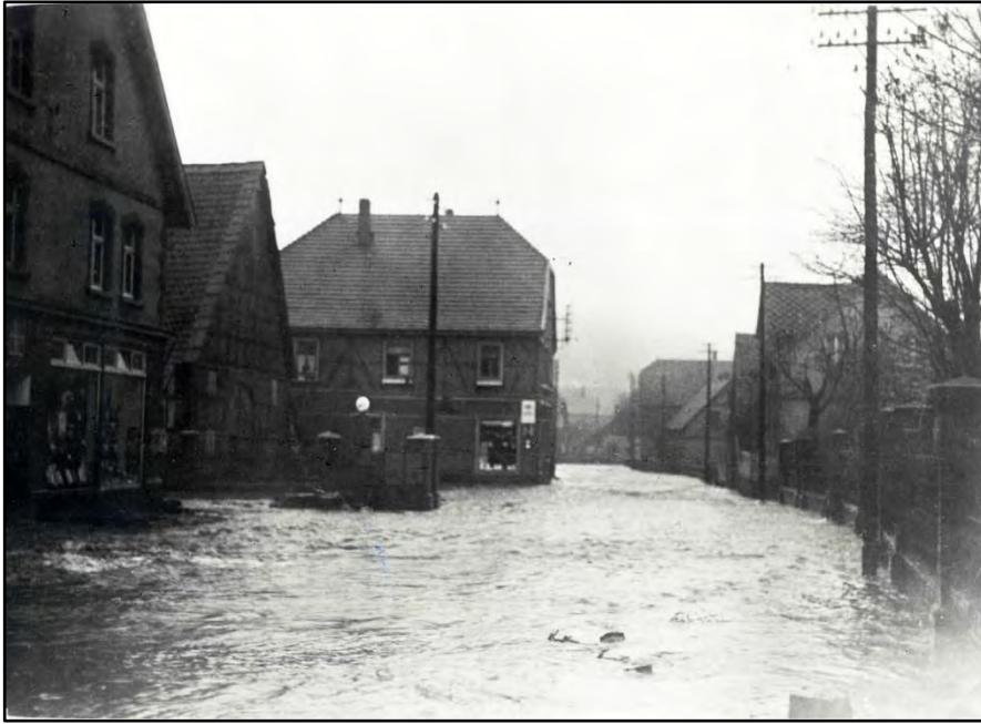
Abb. 34: Hochwasser am 09. Februar 1946, links vorn Kaufhaus Blume, daneben Viets Hof, dahinter die ehemalige Apotheke (Foto Gemeindearchiv Altenbeken)
