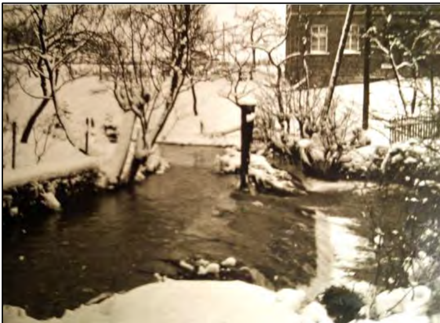
Abb. 43: Beginn/Wehr des Mühlengrabens der Mittelmühle (aus Wasserrechtsakte, Archiv Amelunxen)
