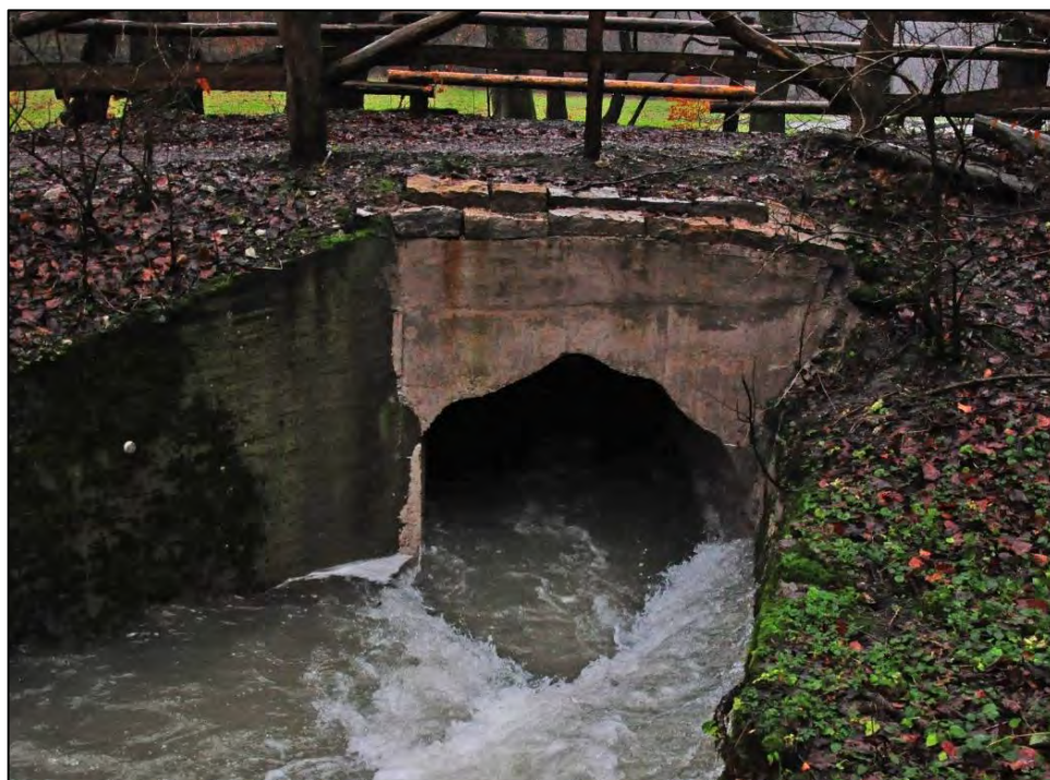
Abbildung 7: Gewölbebrücke nach der Sanierung 2024
