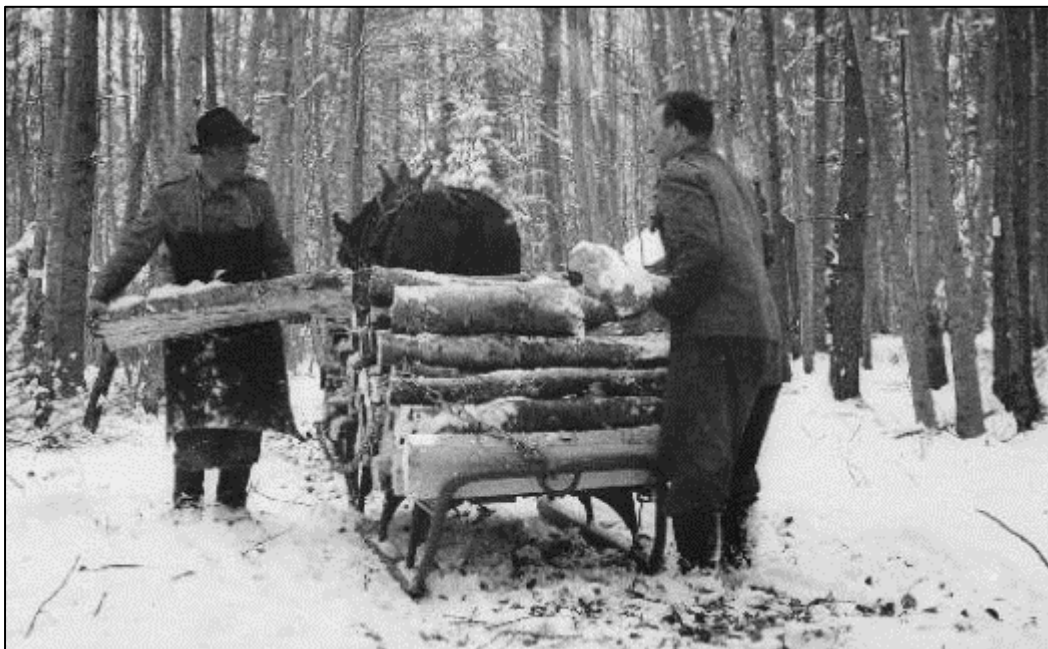
Abbildung 32a: Rückeschlitten für Schichtholz (Quelle: Fotoarchiv WSL Fritz Frutig, Forsttechnik, aus https://www.forstmuseum.ch/holzernte-detail.php?id=3932 , Verfügbarkeit: problemlos)
