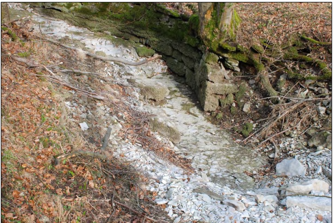
Abbildung 3: Im Bachbett der Durbeke unterhalb der Gewölbebrücke „Klingeweg“ tritt der „blanke Fels“! zu Tage, freigelegt durch Erosion. Die Spalten im Fels begünstigen die Versickerung und den unterirdischen Abfluss des Niederschlagswassers.
