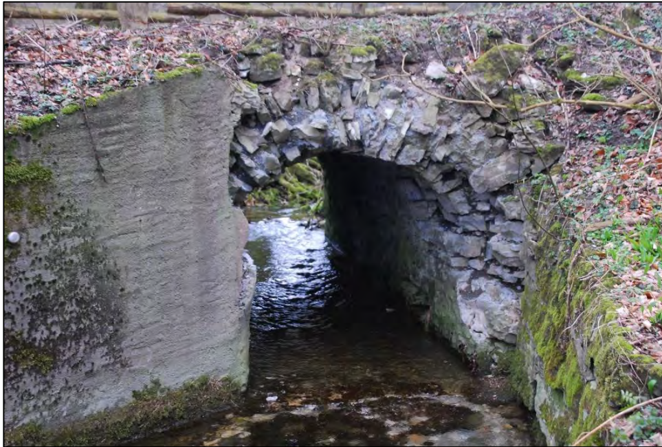
Abbildung 6: Gewölbebrücke vor der Sanierung 2024
