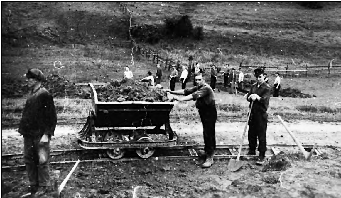
Abbildung 31.: auch bei Ausschachtarbeiten in Altenbeken, Kuhlbornstraße wurden Loren eingesetzt.
