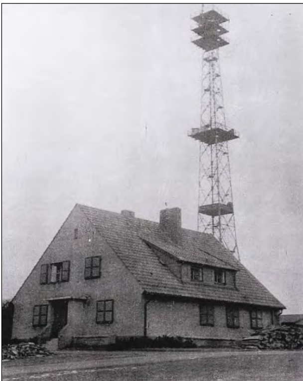
Abb. 04: Wohnhaus des Dienststellenleiters auf dem Mönkeberg, Gittermast mit Richtfunkantennen auf den Plattformen oben und in der Mitte aus Henkenkötter, Geschichte der Luftnachrichtentruppe, 2010, Seite 66)
