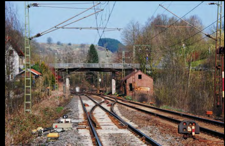
Stellwerk As) ist außer Betrieb. (Foto nach Norden M. Bieling 2015)
