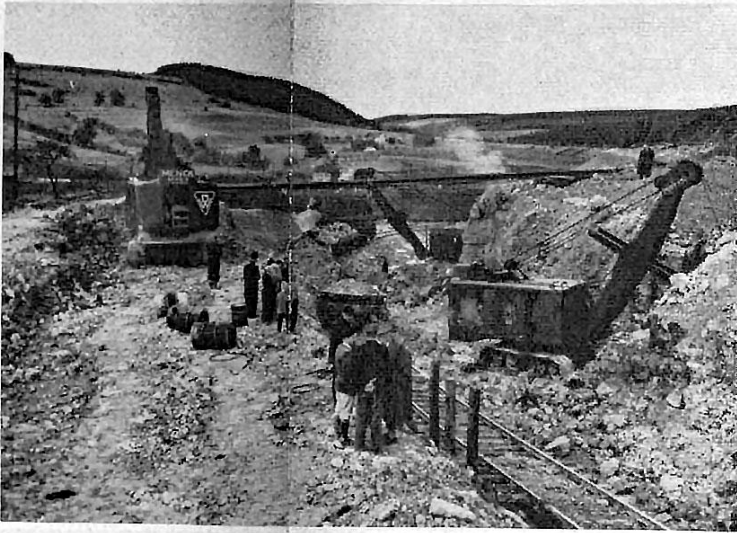
Bild 6: Baggerarbeit und Massenverladung im Voreinschnitt, von der Warburger Seite her gesehen.
