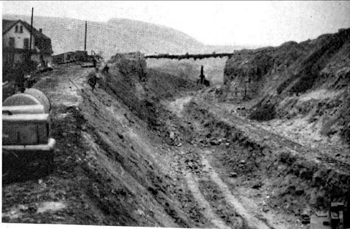
Bild 10: Der Einschnitt der Umgehungsstrecke nach Ausarbeitung einer tieferliegenden Sohle für die Umlegung des Baugleises.
