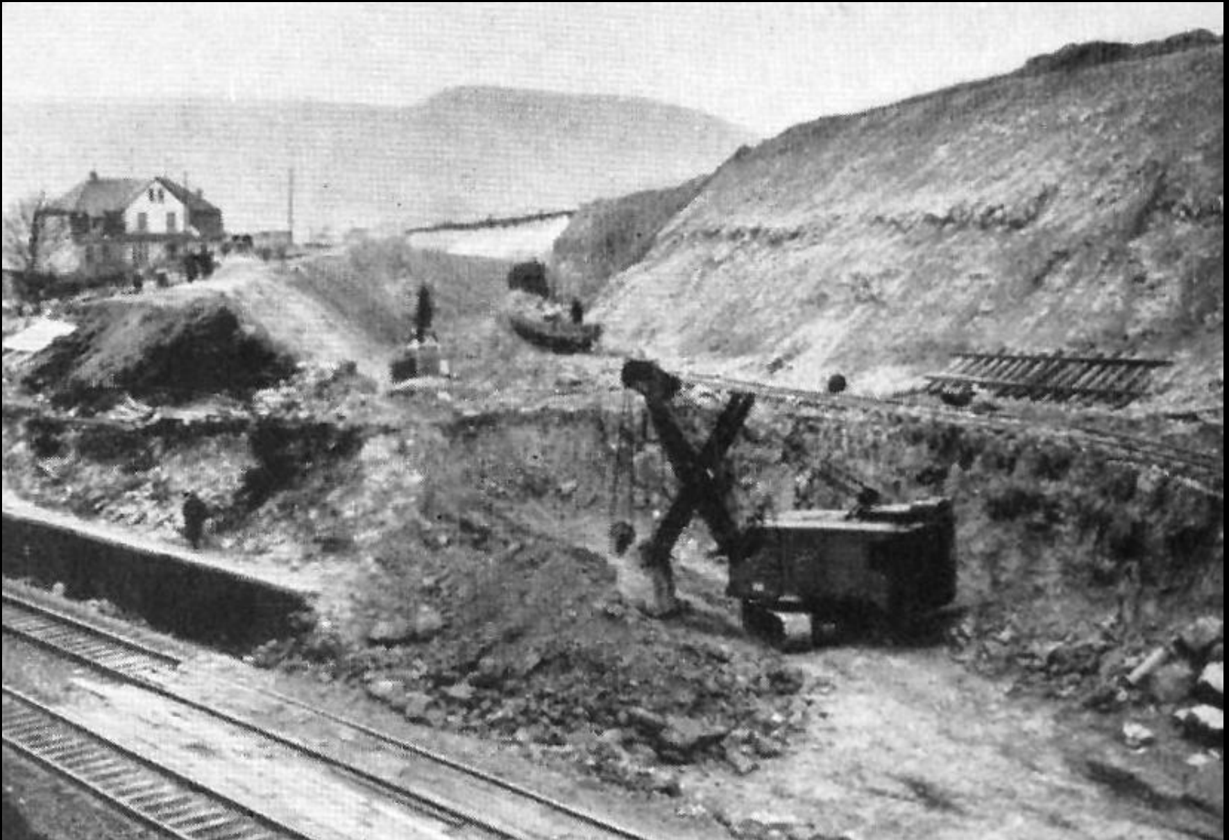
Später wurde noch eine dritte Baustelle im Einmündungsbereich in das Kasseler Gleis eingerichtet, so dass der Abfuhr leicht nach Buke abfahren konnte. (Foto aus ETR 1959, Bild 8)
