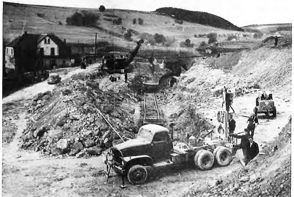
Bild 5: Beladung von Arbeitswagen im Hangabschnitt der Tunnelseite . Im Hintergrund — zwischen den weißen Pfeilen — die Strecke Altenbeken—Langeland. Im Vordergrund ein fahrbares Bohrgerät im Einsatz.
