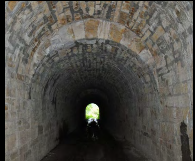
Unterführung Schlone, heute ca. 85 m lang. (Foto 2022)
