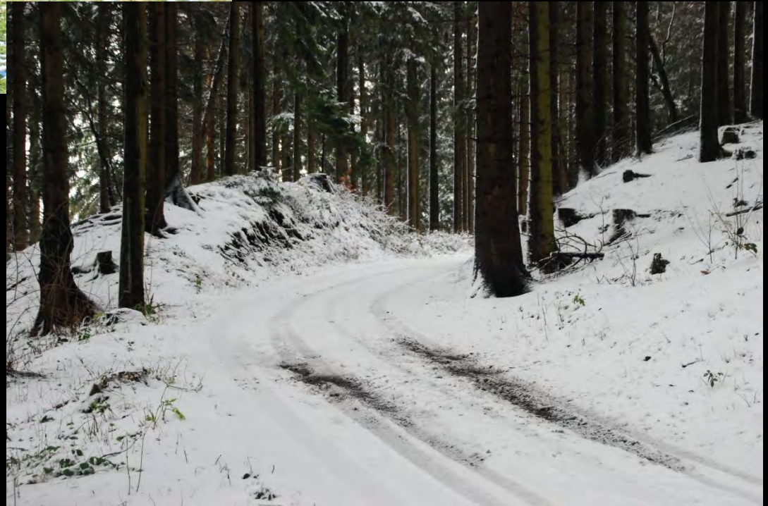
Dammschüttungen beiderseits der Betonfundamente (Foto oben 2025, Foto unten 2017)
